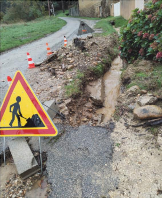
Les fortes précipitations des mois de juin, septembre et octobre dernier ont fortement impacté notre réseau routier. Lens-Lestang, au pied de coteaux, doit se protéger des eaux de ruissellement et favoriser leurs évacuations sans altérer le réseau routier. Plusieurs pièges à gravier sont disposés au bas des combes qui entourent la commune.
